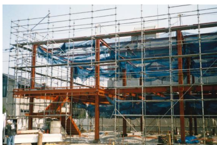
2002年(H14)新築工事鉄骨建方状況
